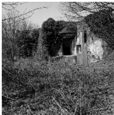
La casemate est.
