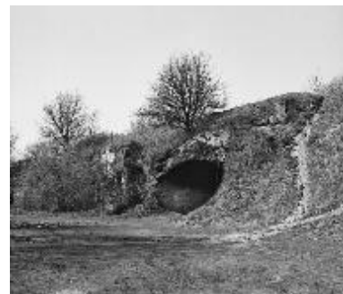
Vestiges du magasin à poudre nord.
