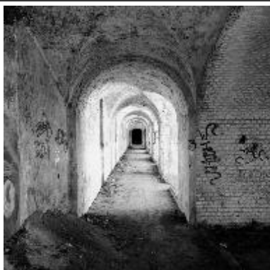
Casernement sud, le couloir desservant les salles.
