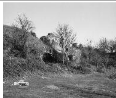
Vue générale de l'aile nord.
