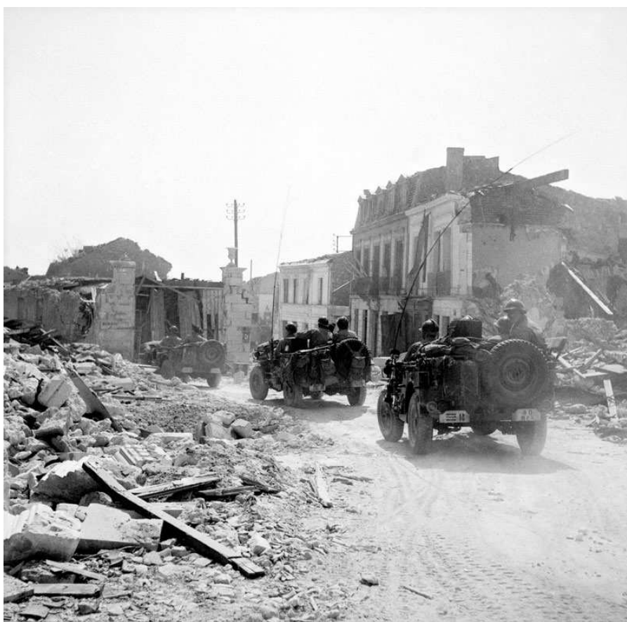
Des éléments de la 2-DB dans les ruines de la ville de Royan.
