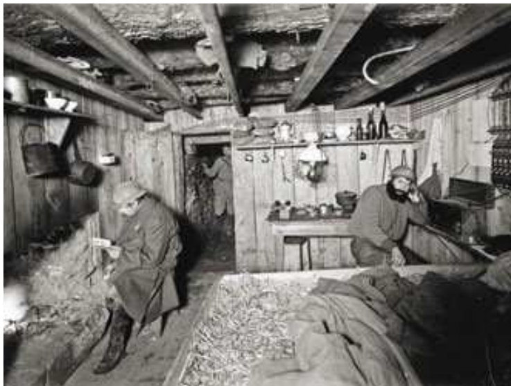
Intérieur aménagé d'une tranchée.
