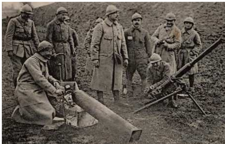
Tir du mortier Mo 60 BRANDT avec une bouteille de gaz comprimé.
